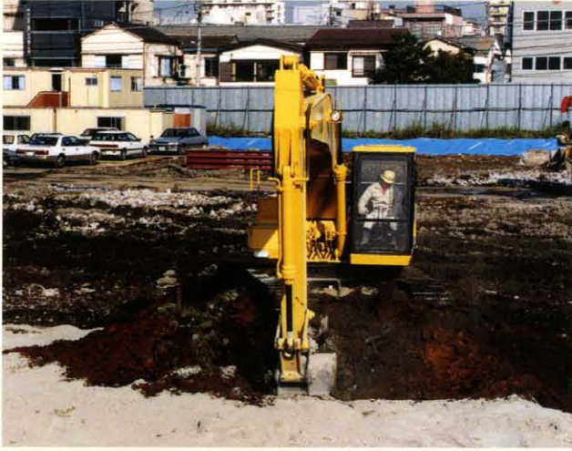
バックホウバケット方式
