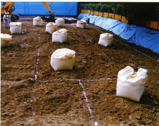
フレコン方式（バックホウ）
