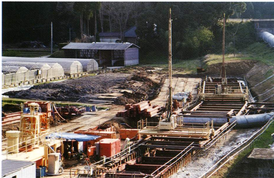
◀陸上仮設による施工例
