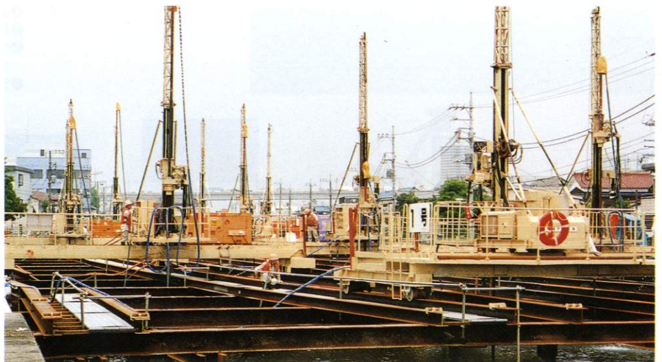
▶河川上のH鋼仮設による施工例
