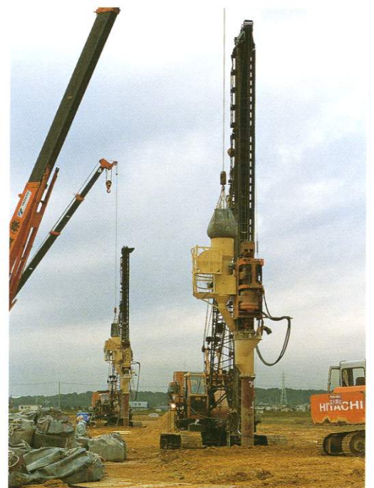
キャッチフォーク型機による短尺施工
