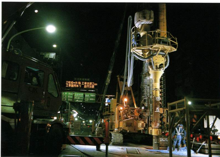
交通渋滞を配慮した低振動・低騒音の夜間施工
