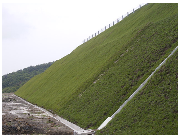
のり面緑化完了
