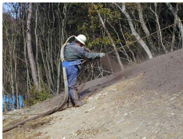
のり面 吹付状況
