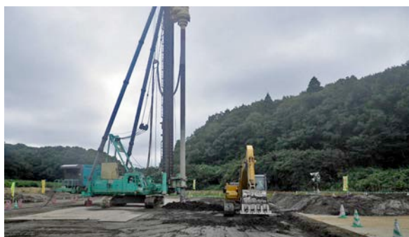
地盤改良(エポコラム工法)施工状況
