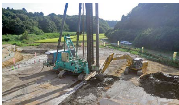
地盤改良(エポコラム工法)施工状況
