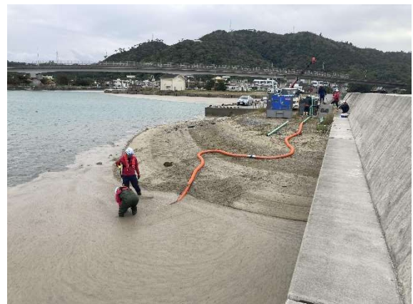
軽石吸水状況
