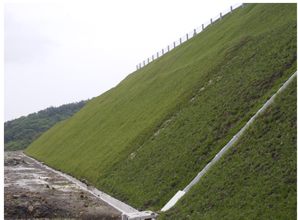
のり面緑化完了
