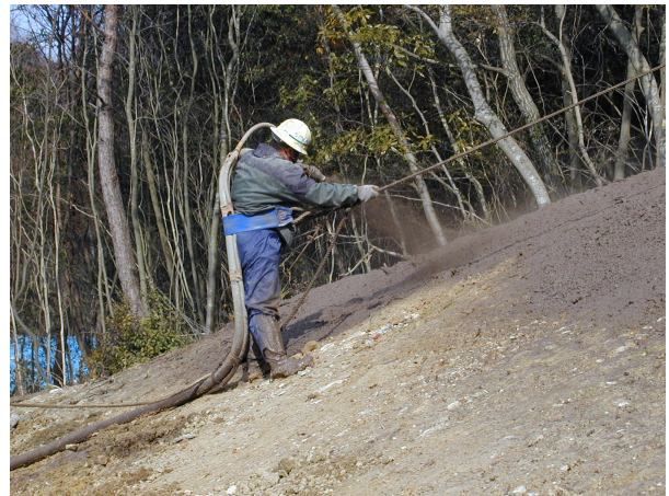
のり面 吹付状況
