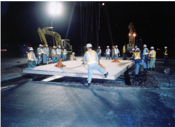
空港滑走路 PC版施工状況
