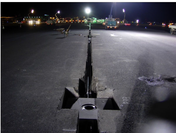
空港滑走路 誘導灯改修
