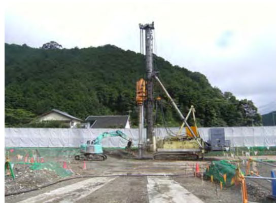
地盤改良（エポコラム工法）施工状況
