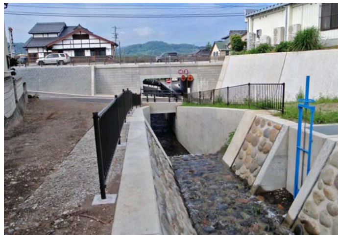
工事竣工写真
