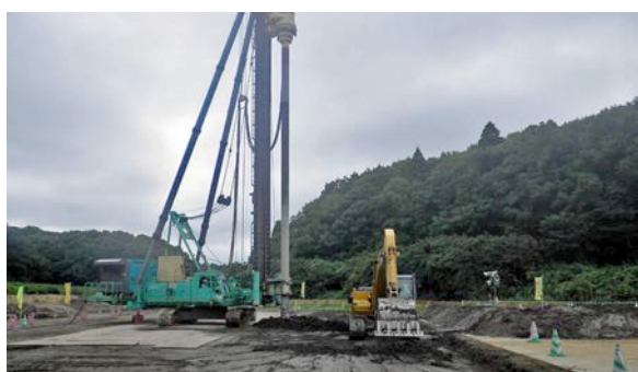
地盤改良(エポコラム工法)施工状況
