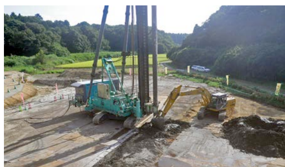
地盤改良(エポコラム工法)施工状況
