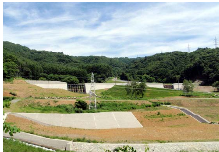
工事完成全景
