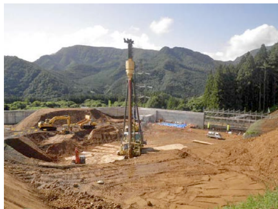
地盤改良(エポコラム工法)施工状況
