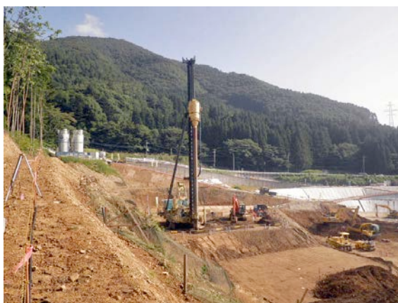
地盤改良(エポコラム工法)施工状況
