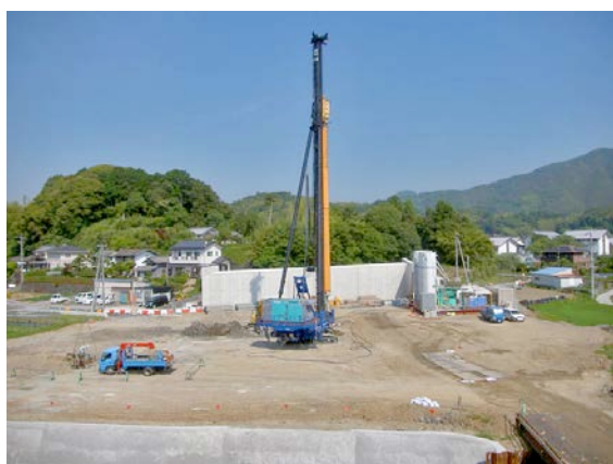
地盤改良(EPO-Loto 工法)施工状況
