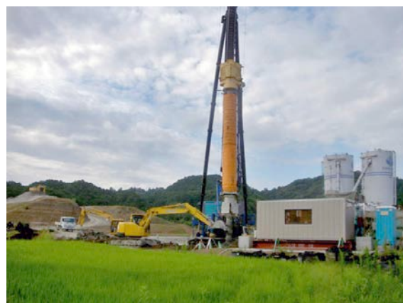
地盤改良(EPO-Loto 工法)施工状況
