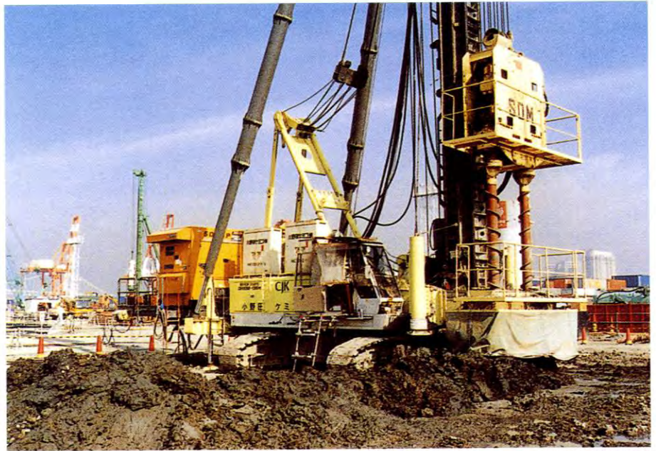
改良時排土状況
