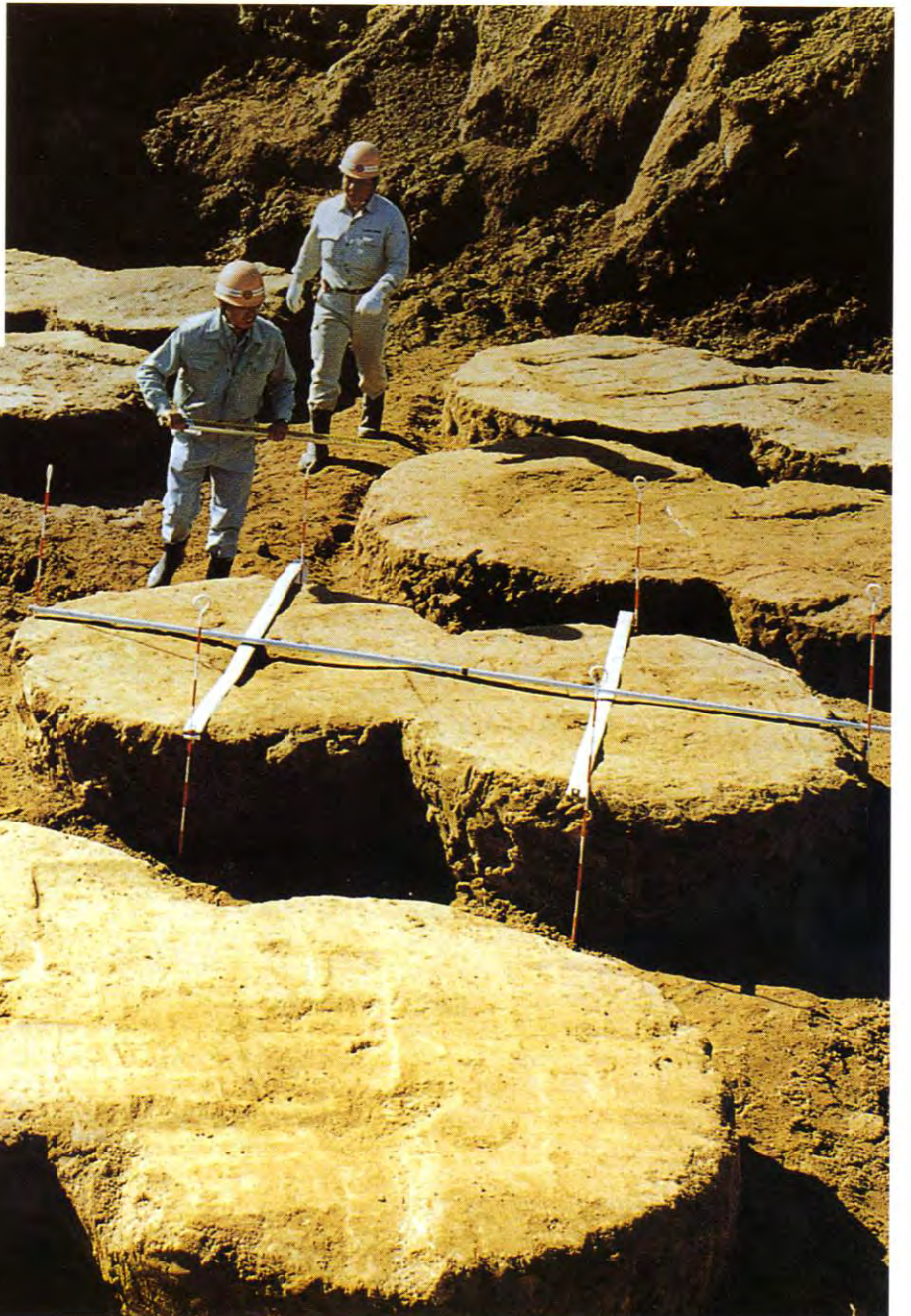
大口径の改良体
