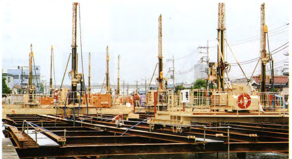
▶河川上のH鋼仮設による施工例
