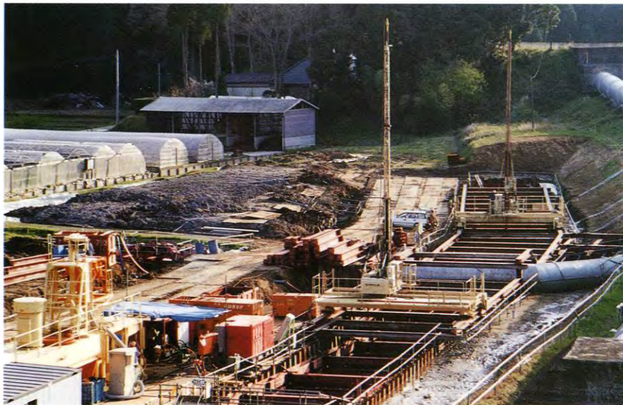
◀陸上仮設による施工例
