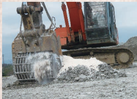
▲バケットスタビライザによる施工状況(粉体添加)
