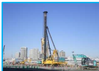
オリンピック関連工事
