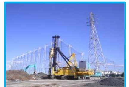
高圧線直下短軸施工
