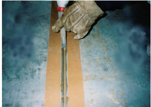
PC版目地材充填状況
