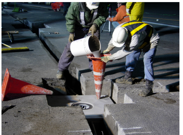
PFG-01 充填状況
