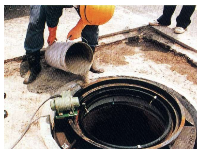
マンホール周り (モルタル)
