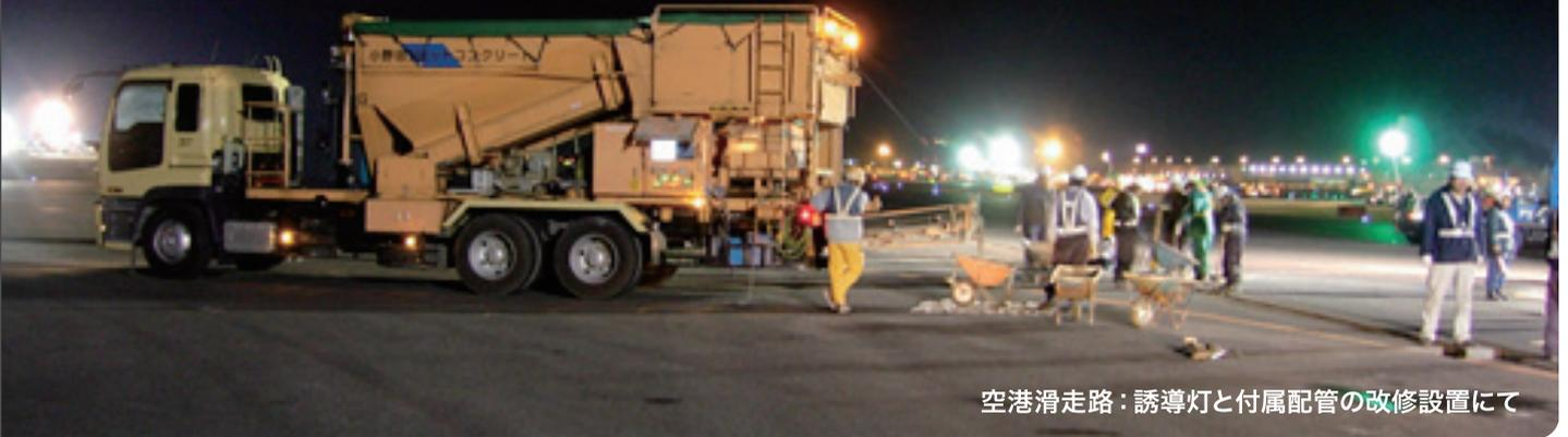
空港滑走路：誘導灯と付属配管の改修設置にて
