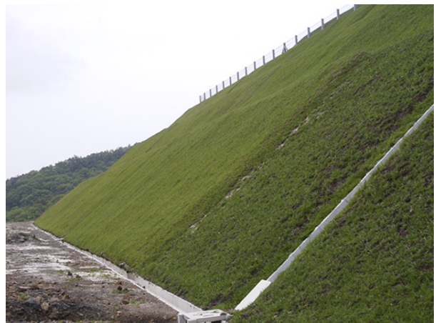
のり面緑化完了
