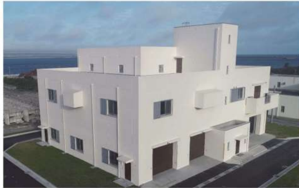
完成した宮古島市し尿等処理施設
