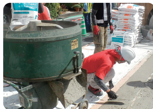
伸縮装置での使用例
